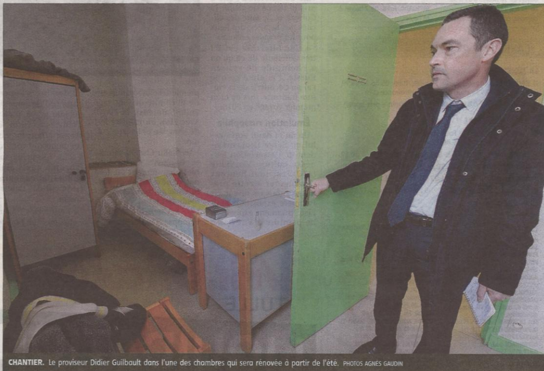
CHANTIER. Le proviseur Didier Guilbault dans l'une des chambres qui sera rénovée à partir de l'été. PHOTOS AGNES GAUDIN
